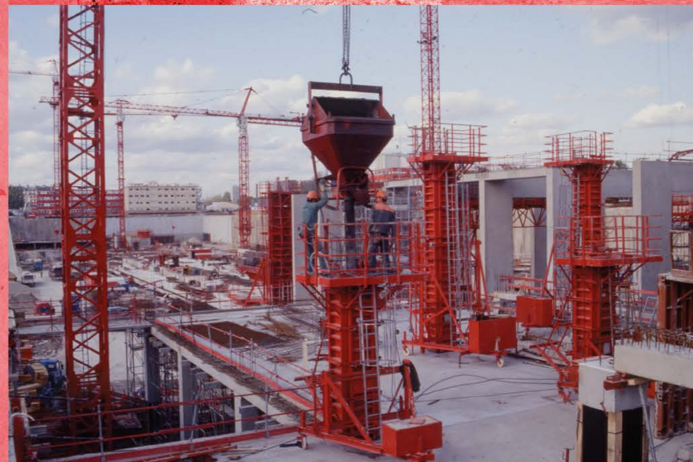
Chantier du site François-Mitterrand, 1992 Photo Philippe Morand
